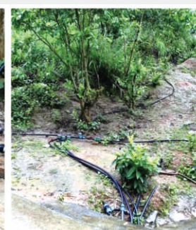
铺设好还未进行掩埋保护的管网
